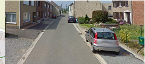
Smalle rijbaan en parken langs of (half) op de rijbaan
