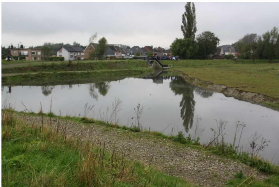
Figuur 8 Zicht op het gecontroleerd overstromingsgebied (GOG) langs de Vondelbeek thv Heizijde, met o.a. dijk en uitlaatkunstwerk (Bron: Het Nieuwsblad)
