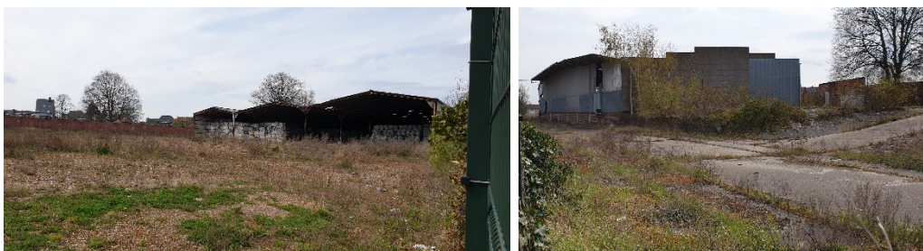
| Gebouwen gesitueerd op deelgebied 1 van de Vanbreuze site
